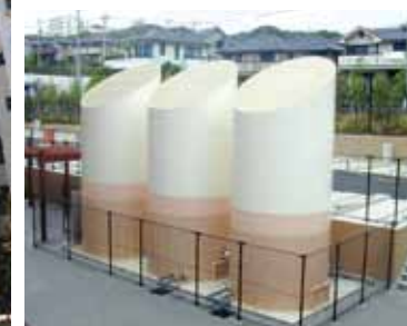
15m 3 デザインタンク×2基+ポンプ室
