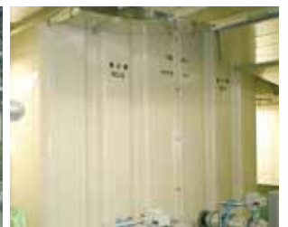
120 m 受水槽 (屋内設置事例)
