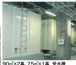
90 m ×2基、75 m ×1基 受水槽 (屋内設置事例)
