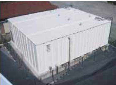
204 m ポンプ室付受水槽
