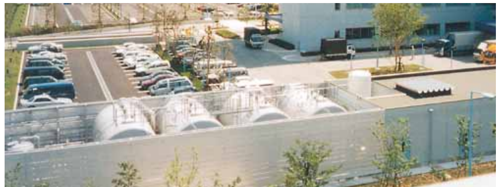
60m 3 ×4基=240m 3 受水槽
