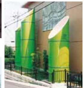
5m 3 デザインタンク×2基+ポンプ室
