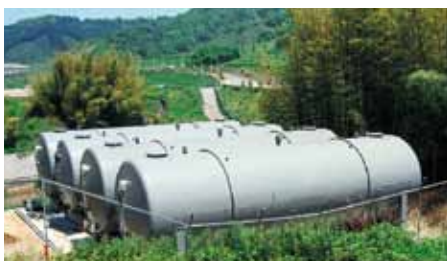
100 m 受水槽×4基
