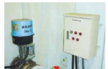
▲緊急遮断弁と制御盤
