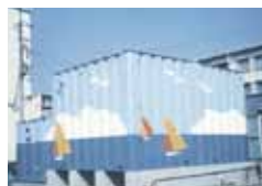
80 m ポンプ室付受水槽
