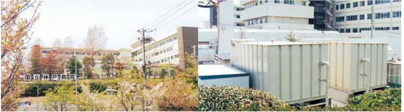
63m 3 ×2基=126m 3 受水槽
